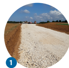
1 Préparation des accès
